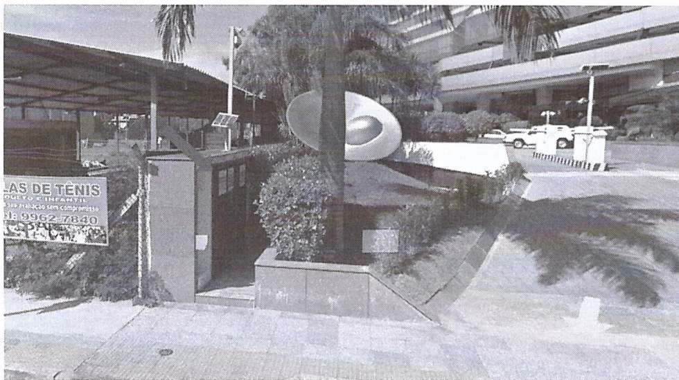
Figura 05 – Vista de uma CRM que alimenta o edifício Global Tower.
