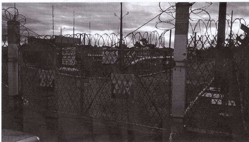
Figura 2 Área de válvula isolada em EDG TIMS - Contorno de Vitória
