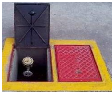
Hidrante de Recalque
