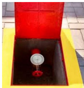
Hidrante de Recalque
