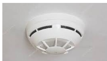
Detectores de calor
