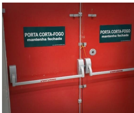
Porta corta fogo com barra anti-pânico
