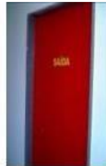
Indicação de acesso a escada de emergência
