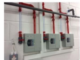
Detector de Fumaça Por Aspiração (VESDA)
