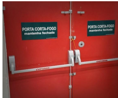
Porta corta fogo com barra anti-pânico
