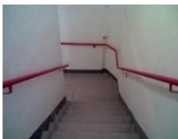
Escada de emergência
