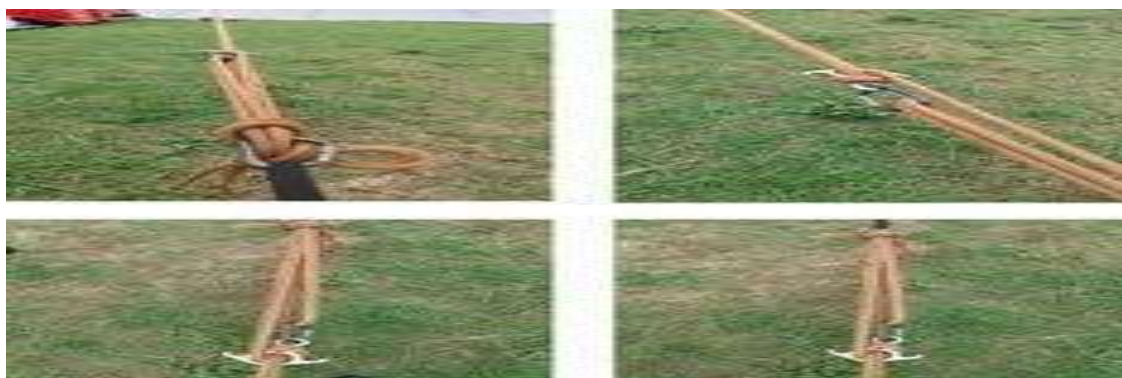
Montagem dos sistema de tracionamento com o freio oito
