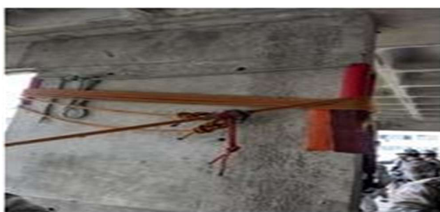
Ponto de ancoragem, utilizando voltas sem tensão
